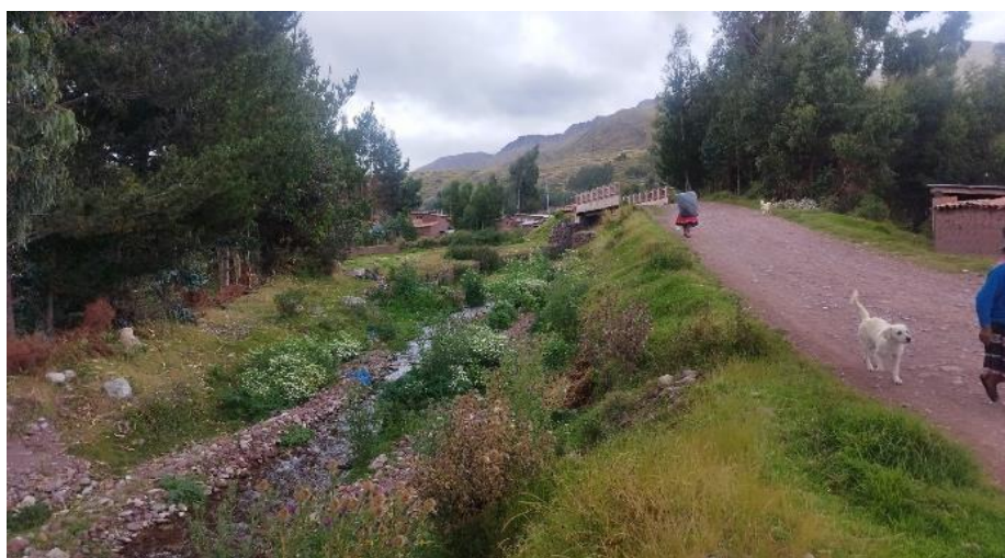
FIGURA N° 02: SE APRECIA EL CAUSE ESTRANGULADA, EL CUAL INTERRUMPE EL NORMAL FLUJO DEL AGUA, REQUERIENDO LA LIMPIEZA Y DESCOLMATACIÓN DEL CAUCE DE LA QUEBRADA URA PALLPA.
